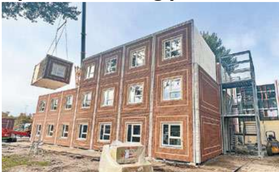
De laatste modules worden geplaatst bij Windesheim. Foto: Windesheim en Openbaar Belang.
