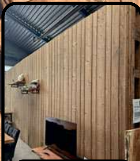
Thermowood gevel/ wand bekleding
