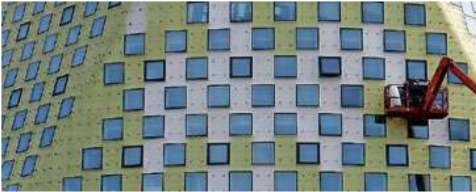
Tijdens de bouw van het gemeentehuis in 2012 waren de diverse lagen van de gevelafwerking te zien. Eigen foto.
