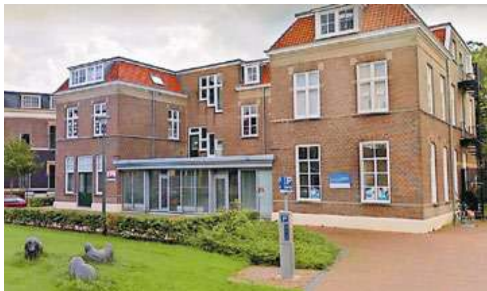
De achterzijde van het pand, met het gezellige plantsoentje. Foto Google Streetview.
