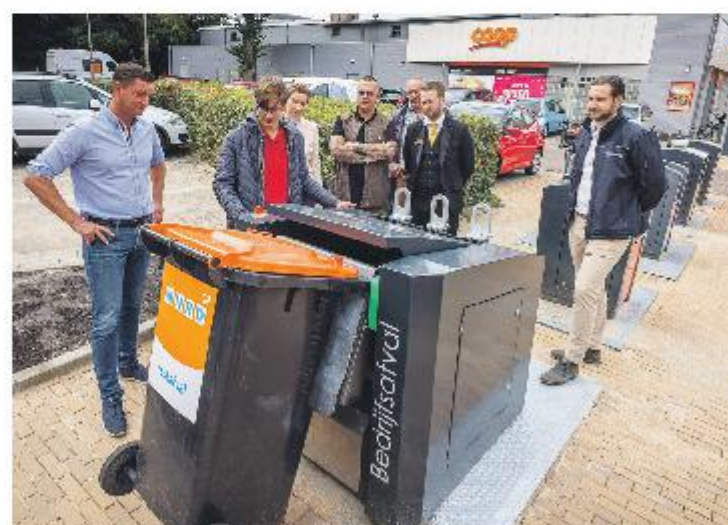
Wethouder Bram Harmsma (links) nam de nieuwe ondergrondse afvalcontainer voor bedrijfsafval in Steenwijk officieel in gebruik. Foto: gemeente Steenwijkerland
