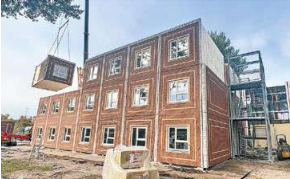
De laatste modules worden geplaatst bij Windesheim. Foto: Windesheim en Openbaar Belang.
