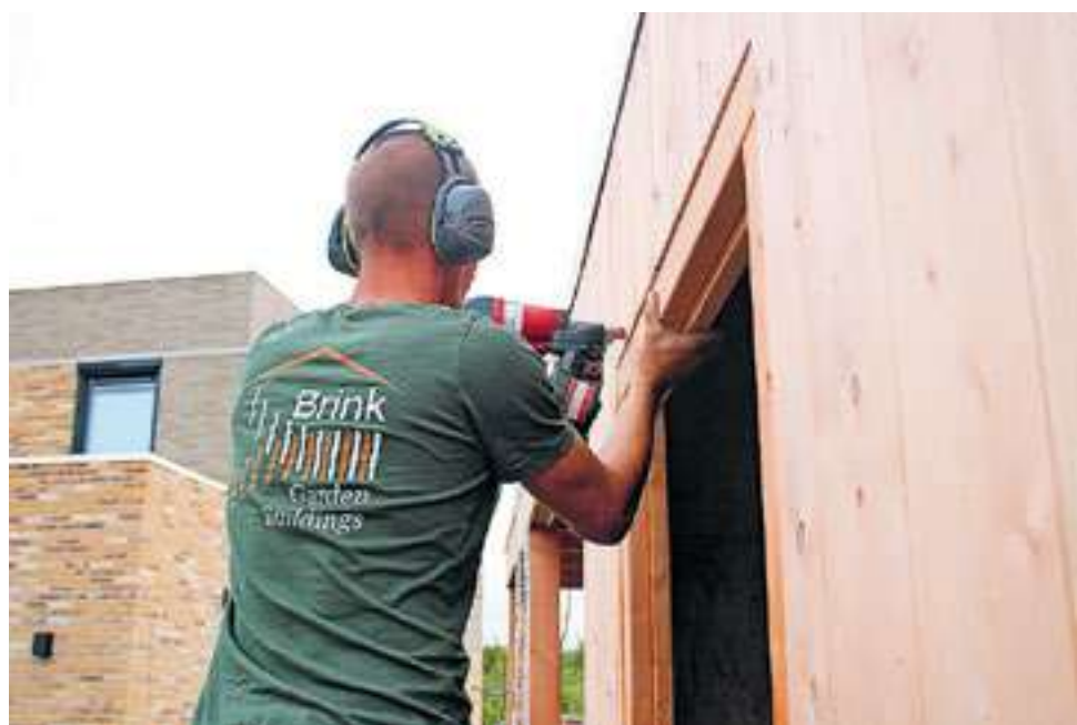
Ondergrond en het tuinhuisje: alles van a tot z wordt in de tuin gemonteerd. Eigen foto's
