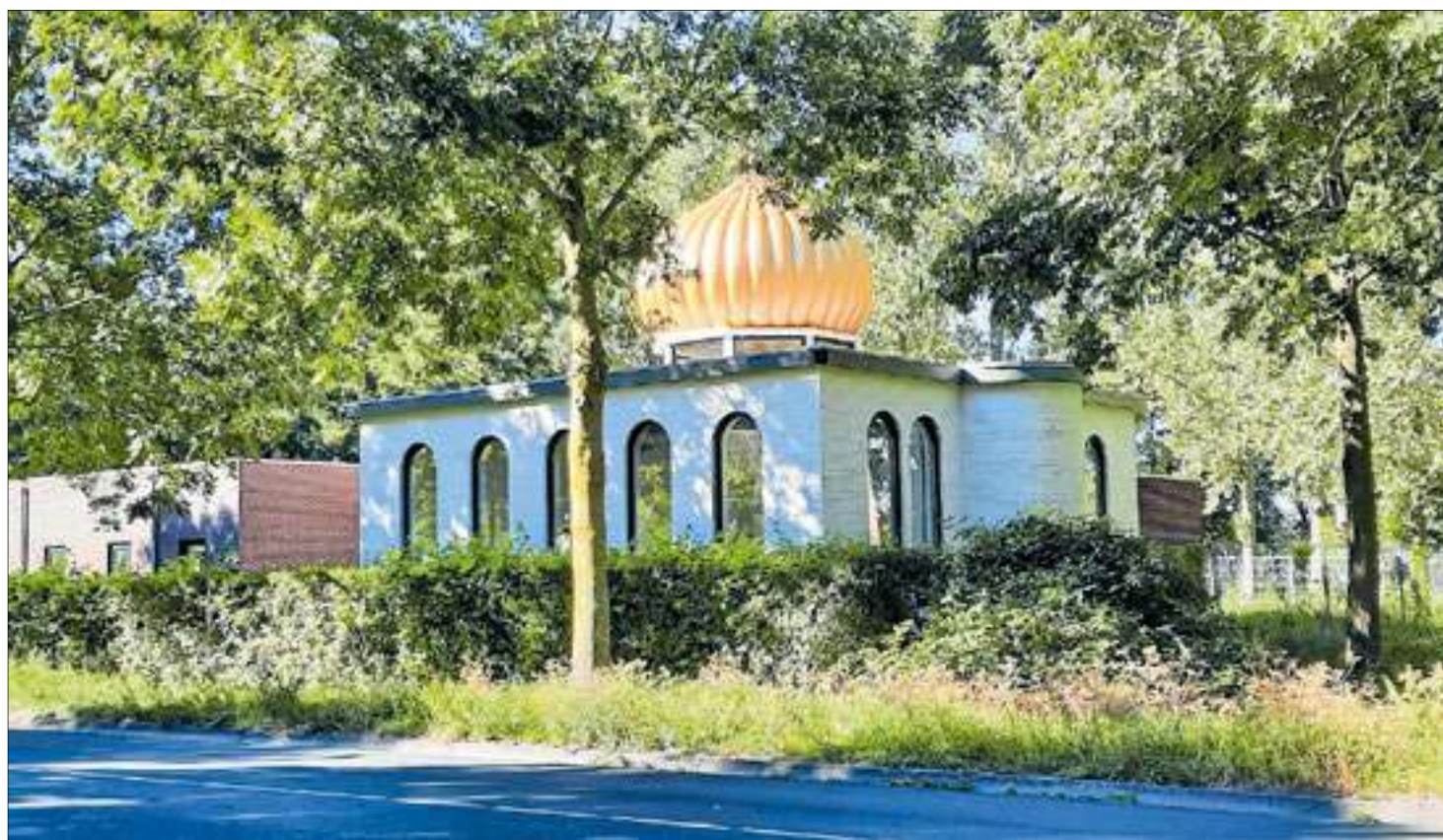
De koepel zit erop, nu is het nog wachten op de minaret. Foto: Roy Visscher
